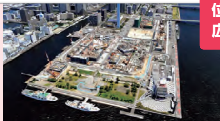
臨海部の東京オリンピック・パラリンピック選手村建設現場(2018年 東京都中央区)
