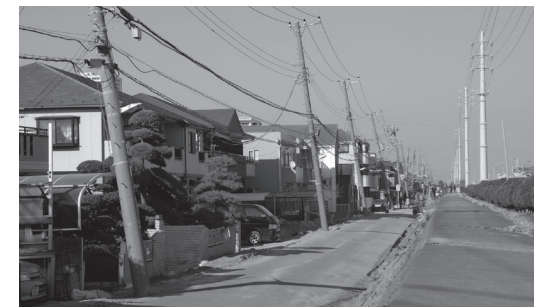
液状化現象によってかたむいた電柱
