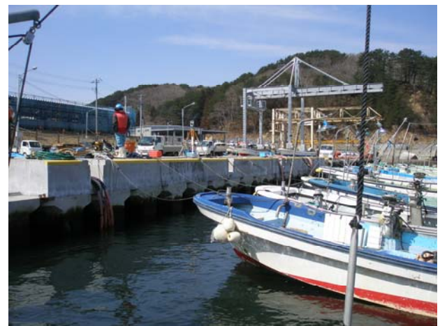
▲船が並ぶ音部漁港。まだ工事中の部分も少なくない
