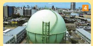
4 ガスホルダーはガスを一時的に貯めておく施設です。 貯めておくことにより、ガスの使用量が多くなる時間帯でもガスを送ることができます。
