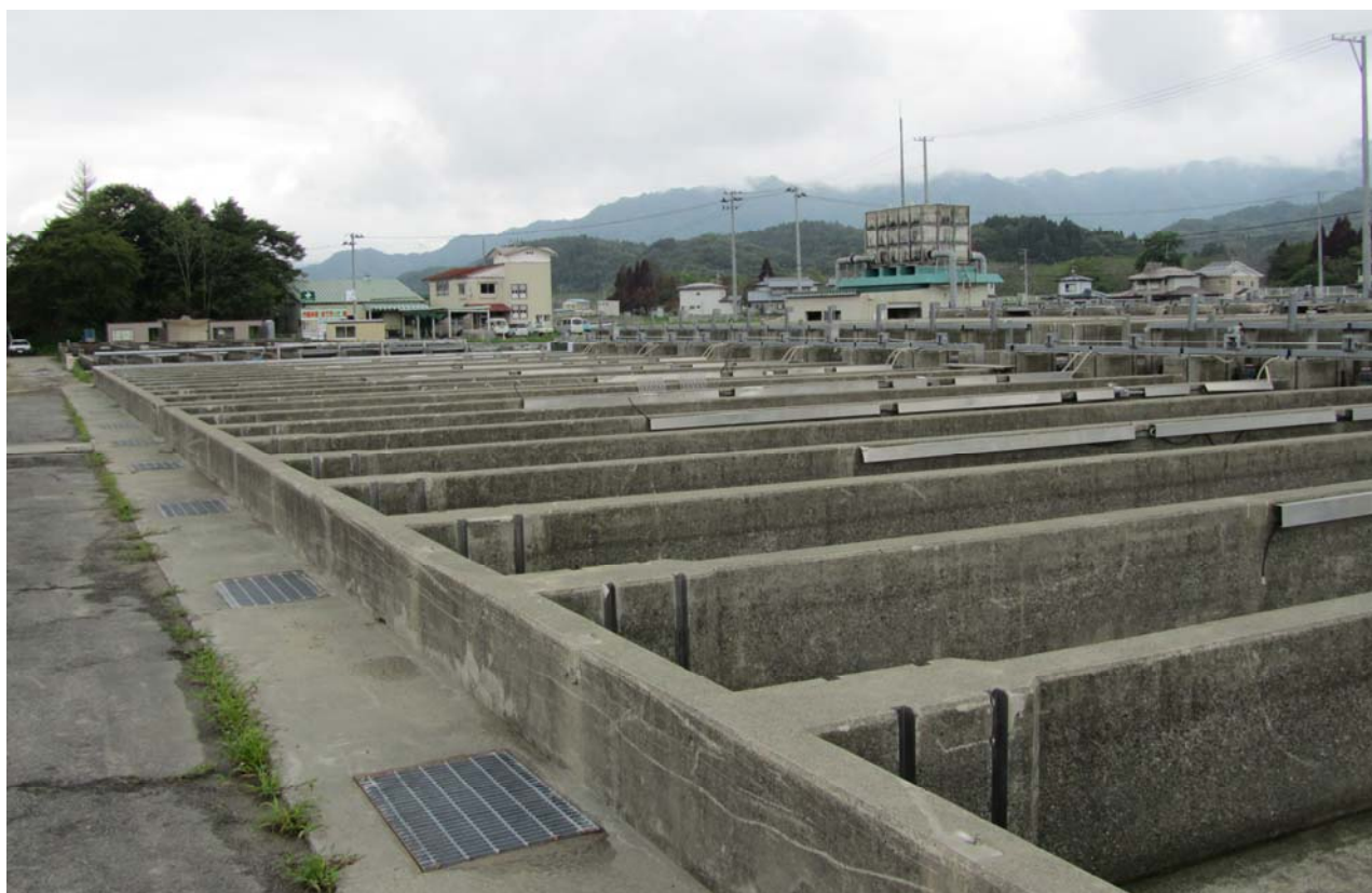
▲津軽石ふ化場。赤い屋根の2階建ての建物が事務所になっている
