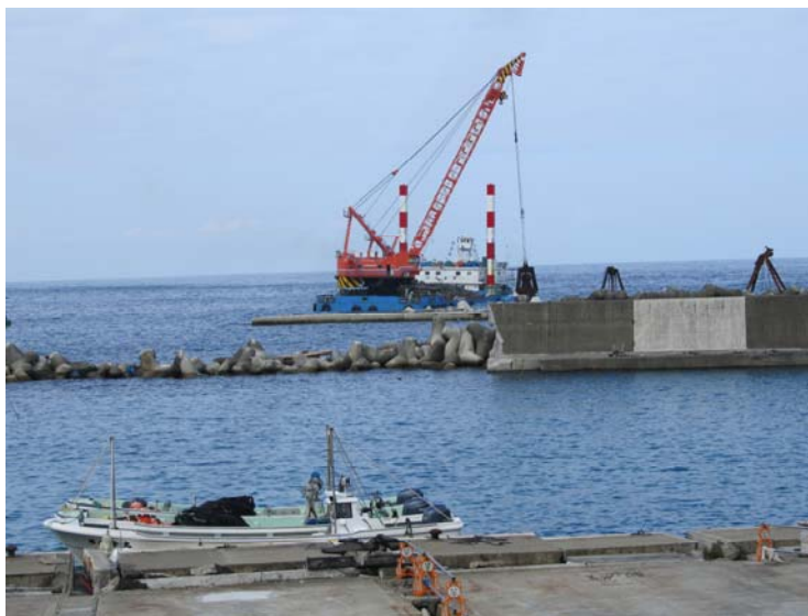
▲漁港では、クレーンが動いて復旧作業を進めていた
