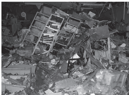
▼1階の収蔵庫の被災状況
